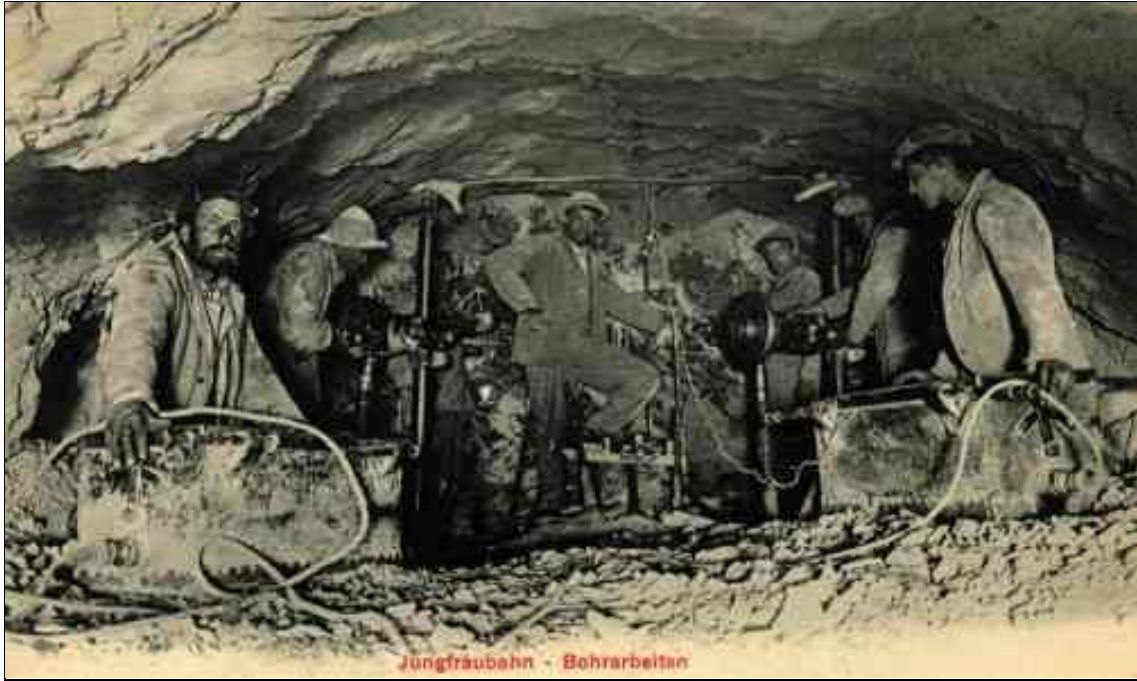
Trabajos de construcción del ferrocarril de la Jungfrau (antigua postal obtenida de Wikipedia Commons, c. 1900)
